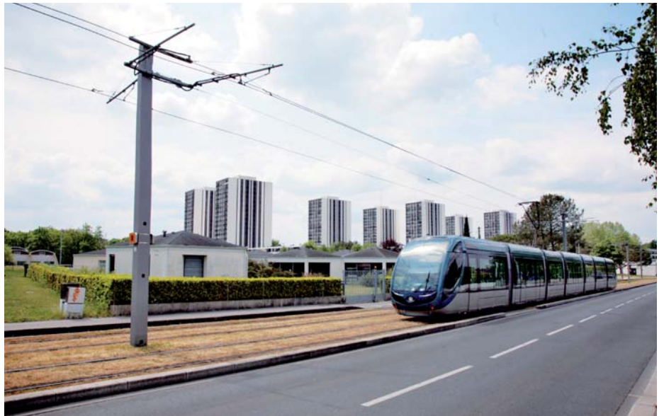
Les travaux de préparation à l'extension du tramway débutent cette année
